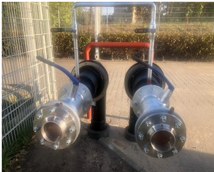
Przyłącze w miejscu włączenia wymiennikowni
